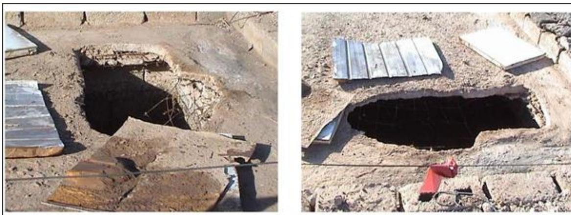
دو نمونه فرسودگی و ریزش سقف انباره‌های فاضلاب
